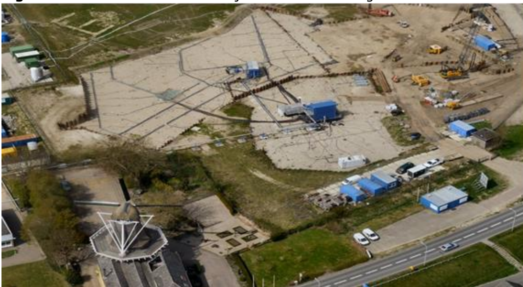
Figuur 3: Olasfa-terrein in 2015 tijdens stoomsanering 4
